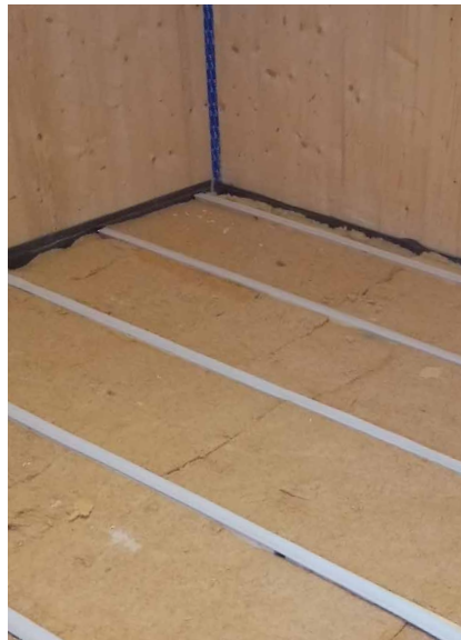
Einbau des Trockenbausystems mit PIANO
